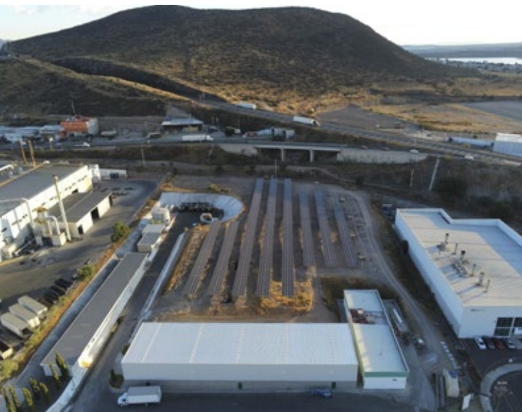
Fotovoltaikanlage am Standort Querétaro, Mexiko
